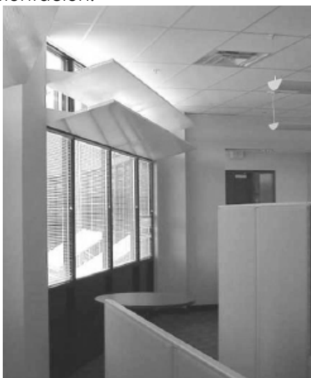
Fig. 10.14. Redirección de luz natural a través de pantallas ubicadas en las partes altas de las ventanas
