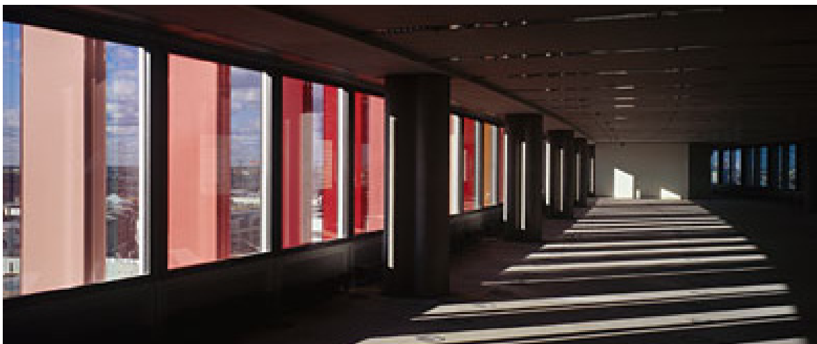
Fig. 10.9 Edificio GSW en Berlín, Alemania, Arquitectura: Sauerbruch-Hutton, donde los alerones verticales de orientación oeste son practicables, cambiando sus posiciones según los requerimientos.
